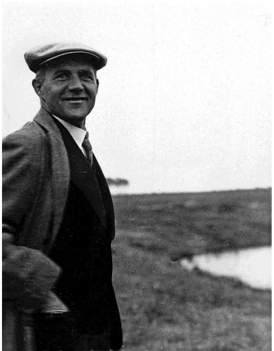
Hannes Meyer bei der Begehung des Baugeländes für die Bundesschule des ADGB in Bernau, 1928 / Stiftung Bauhaus Dessau (I 46037/1-2), Foto: Hermann Bunzel
